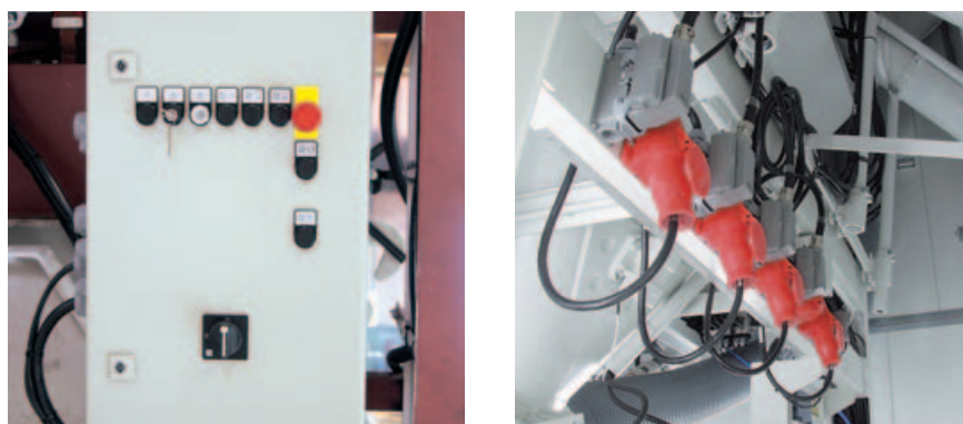
Разъемные контактные соединения для электрического подключения периферийного оборудования упрощают монтаж и демонтаж.
